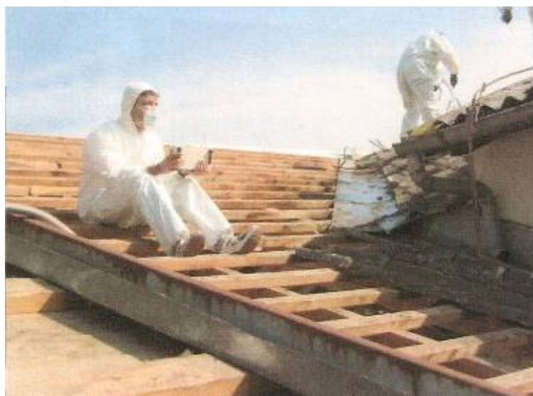
Slika 26: Merilno mesto 3 vsebnosti azbestnih vlaken v zraku
