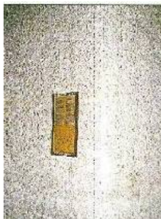
Slika 8: Omet, ki vsebuje azbest
