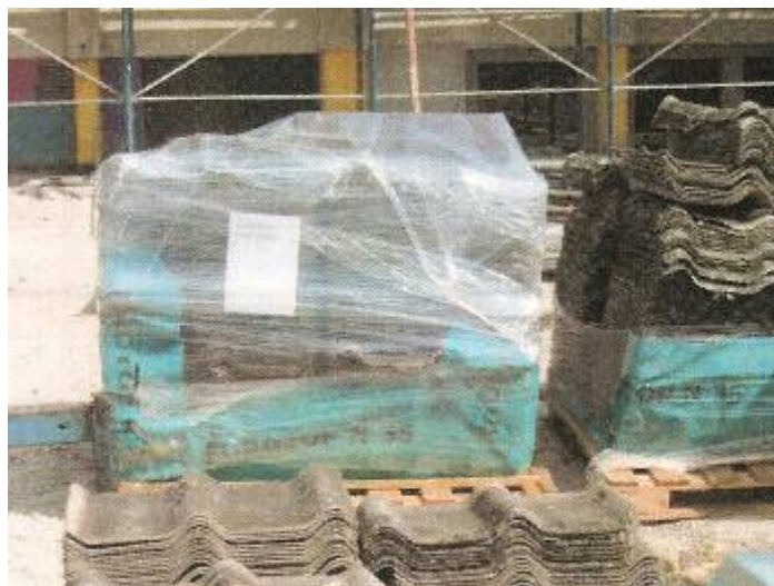
Slika 23: Pravilno embaliranje azbestne kritine
