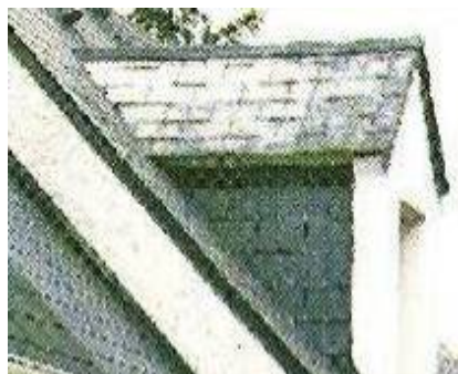
Slika 15: Azbest-cementna kritina - ravne skodle
