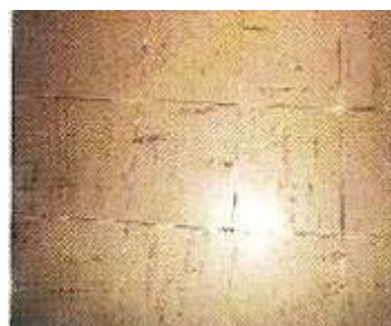
Slika 18: Talne plošče iz vinil azbesta
