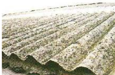
Slika 5: Azbest-cementna kritina - valovite salonitke
