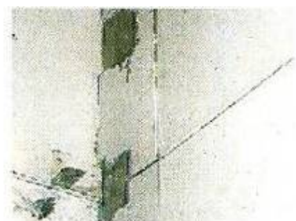
Slika 11: Stena, obložena z azbestnimi ploščami
