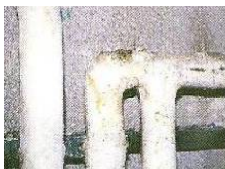
Slika 10: Cevi, izolirane z azbestom
