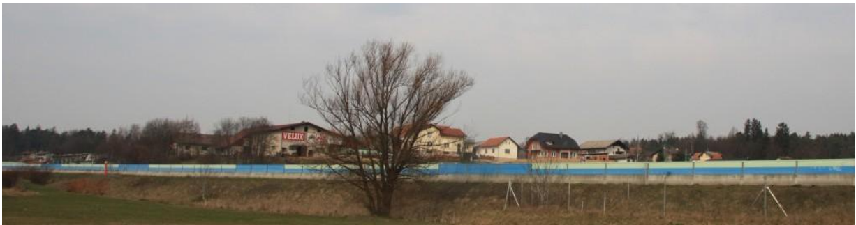
Slika 11: Protihrupna ograja ob avtocesti Ljubljana – Maribor (izhod Celje – center) Foto: V. Šoster, marec, 2010
