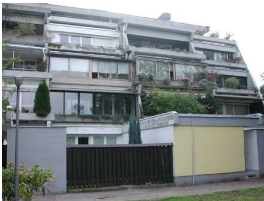
Slika 33: Zasteklitve fasade na bloku
