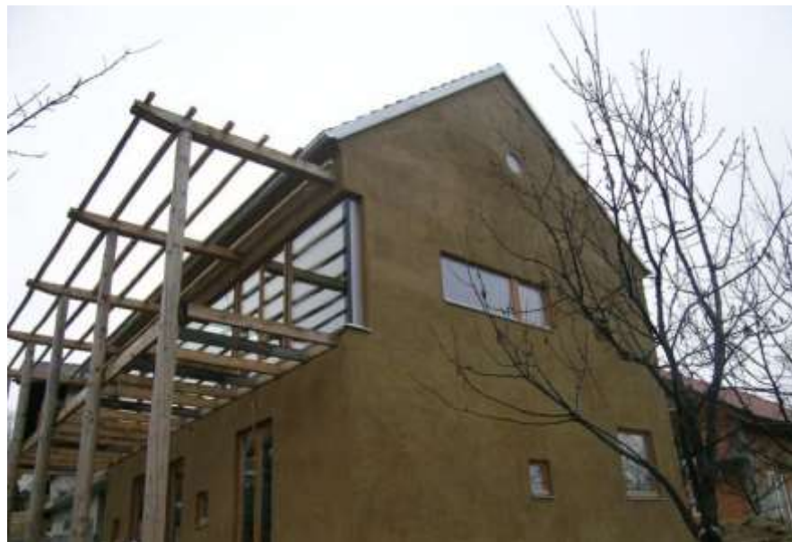
Slika 48: Primer obnovljenega starega objekta v zeleno gradnjo
