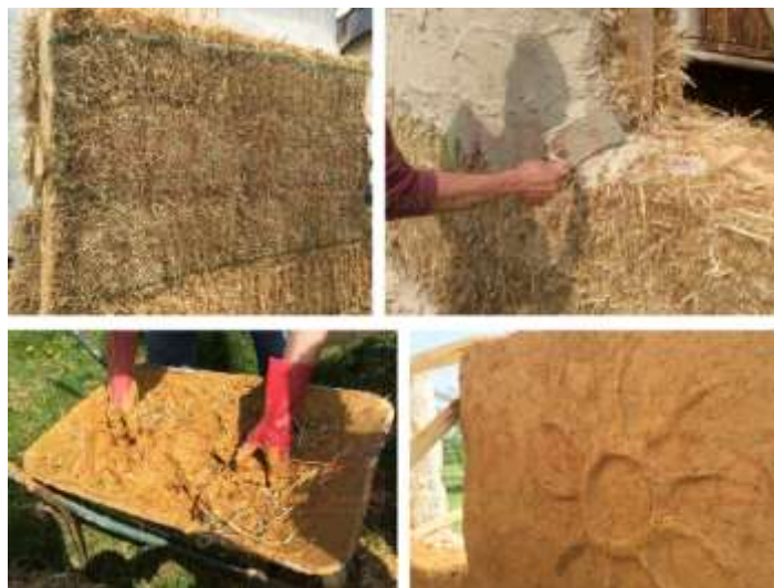
Slika 12: Primer gradnje z slamnatimi balami
