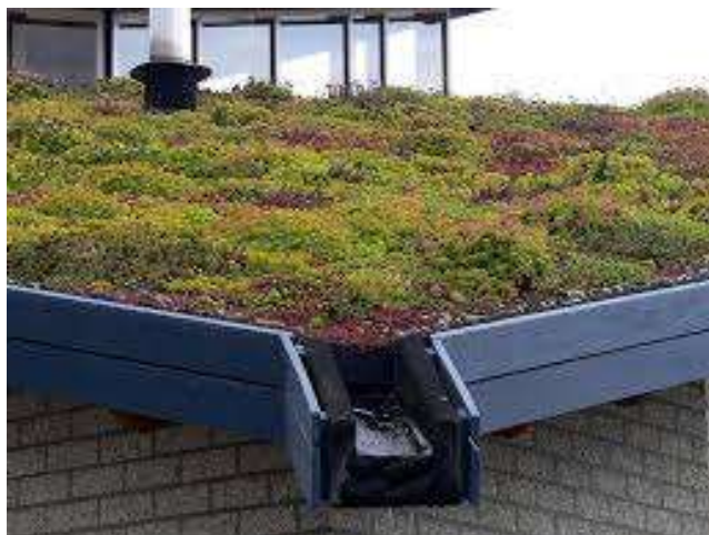
Slika 38: Ekstenzivna ozelenitev ravne strehe
