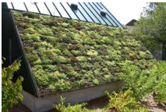
Slika 39: Ekstenzivna ozelenitev strehe z naklonom
