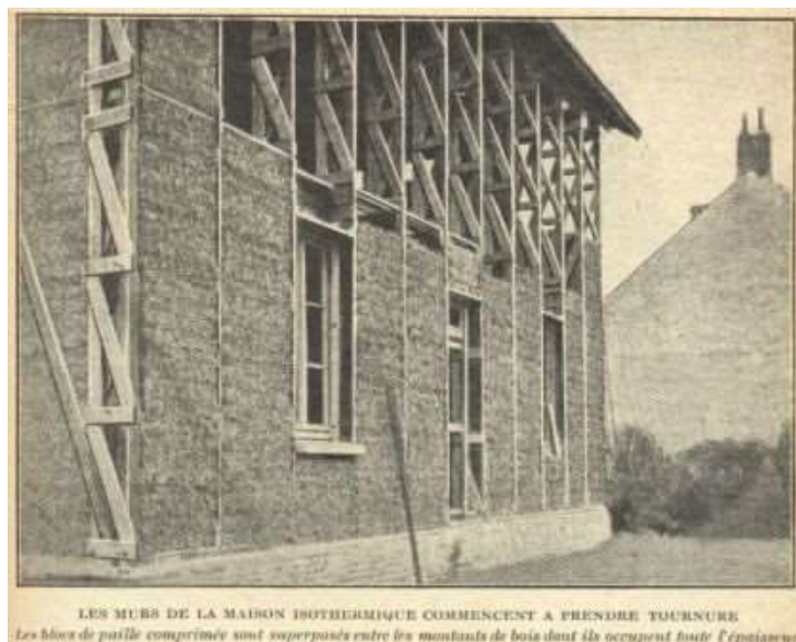
Slika 13: Konstrukcija najstarejše hiše slamnatih kock
