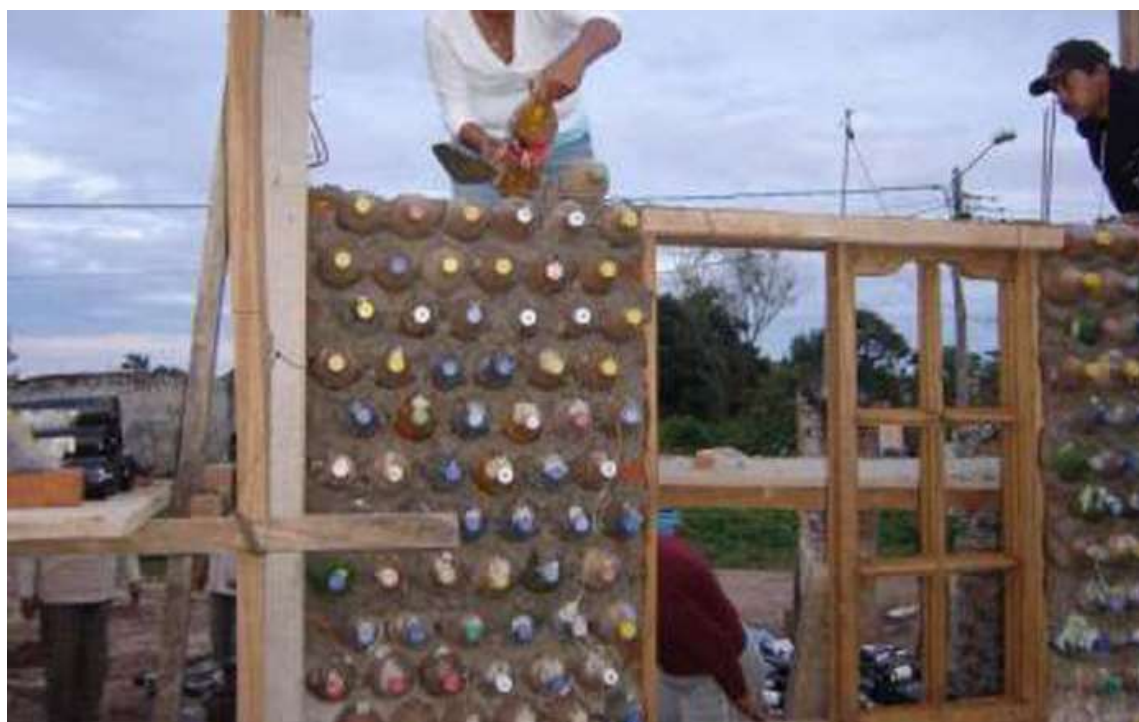
Slika 6: Primer gradnje hiše iz plastenk
